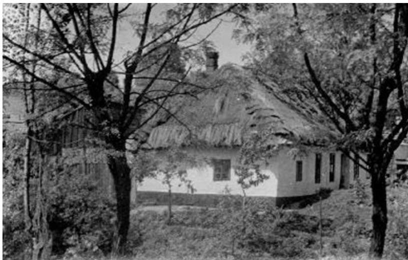
Nahoře: Usedlost č.p. 16 (bývalá rychta)
